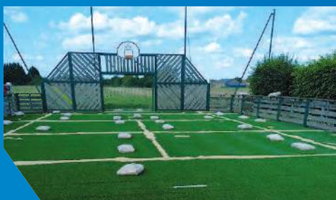
City stade : rénovation du sol
