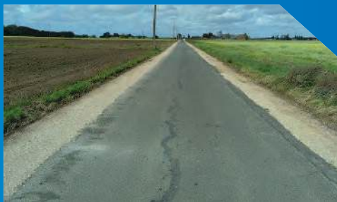
Rue Verte : rénovation des accotements
